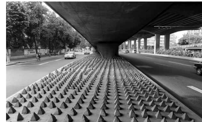
Šiljci postavljeni ispod nadvožnjaka u Kini (Guangzhou city, Guangdong). Izvor: Guardian.com
