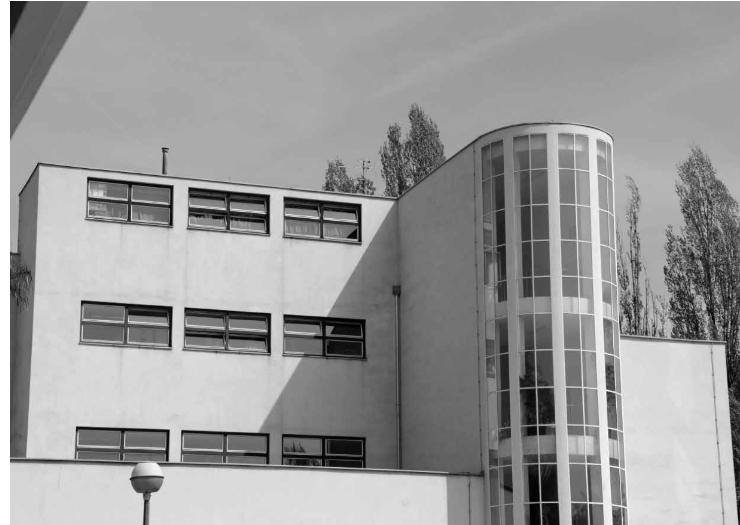
Osnovna škola Augusta Šenoje na Selskoj cesti 95 izgrađena je prema nacrtima arhitekta Ivana Zemljaka 1931., prije naselja Prve hrvatske štedionice, za djecu uglavnom siromašnih radničkih obitelji tada neizgrađene Trešnjevke. Tlocrt je razveden u tri dijela, a u školskom dvorištu se kraj sportskih terena nalazio i plitki bazen, zatrpan tijekom kasnijih intervencija.
